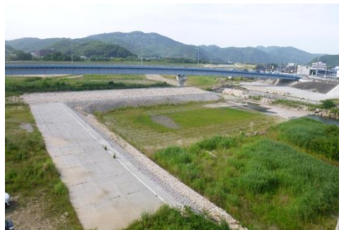
二の荒手 完成状況
