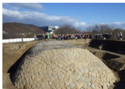
巻石部 解体前
